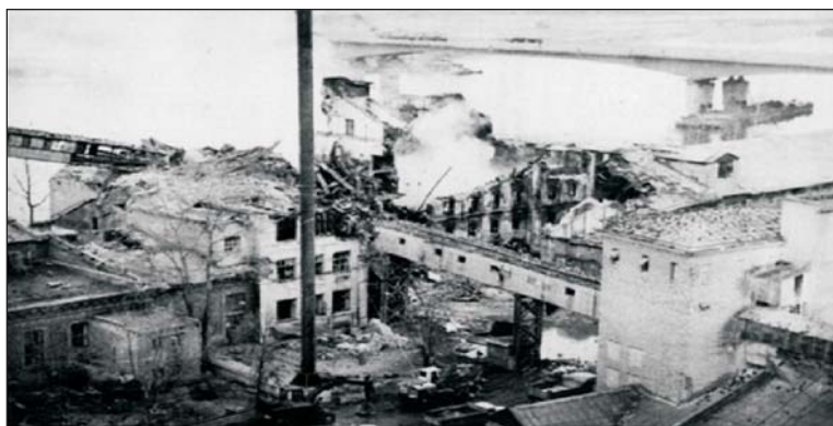
Рис. 1. Последствия взрыва муки на мелькомбинате (г. Тверь, 1981 г.)
